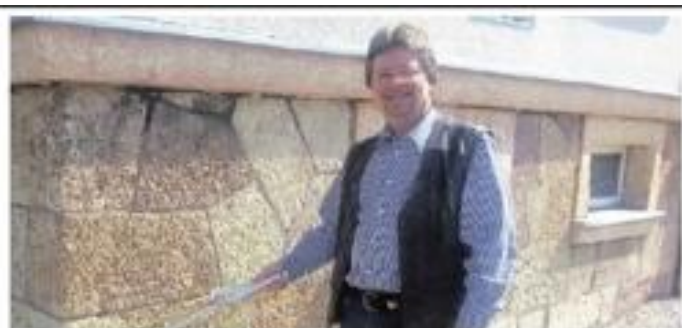
Ein Einsatz, der sich lohnt: „Unser Verfahren ist preiswert, wirksam, langlebig, wartungsfrei und umweltfreundlich“, sagt Mathias Wiese, Gebietsleiter bei Drymat Systeme.
